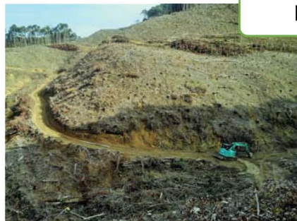
武雄市若木町伐採中の写真
