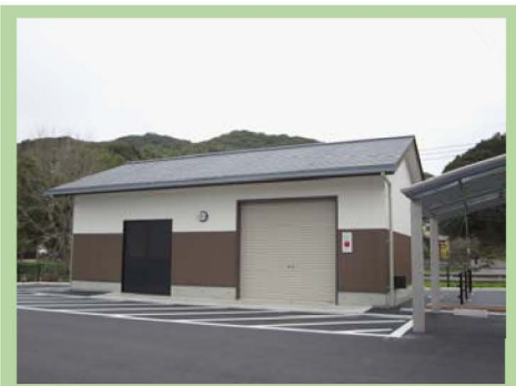
武雄市朝日町消防団 消防格納庫 ▶2022年4月1日
